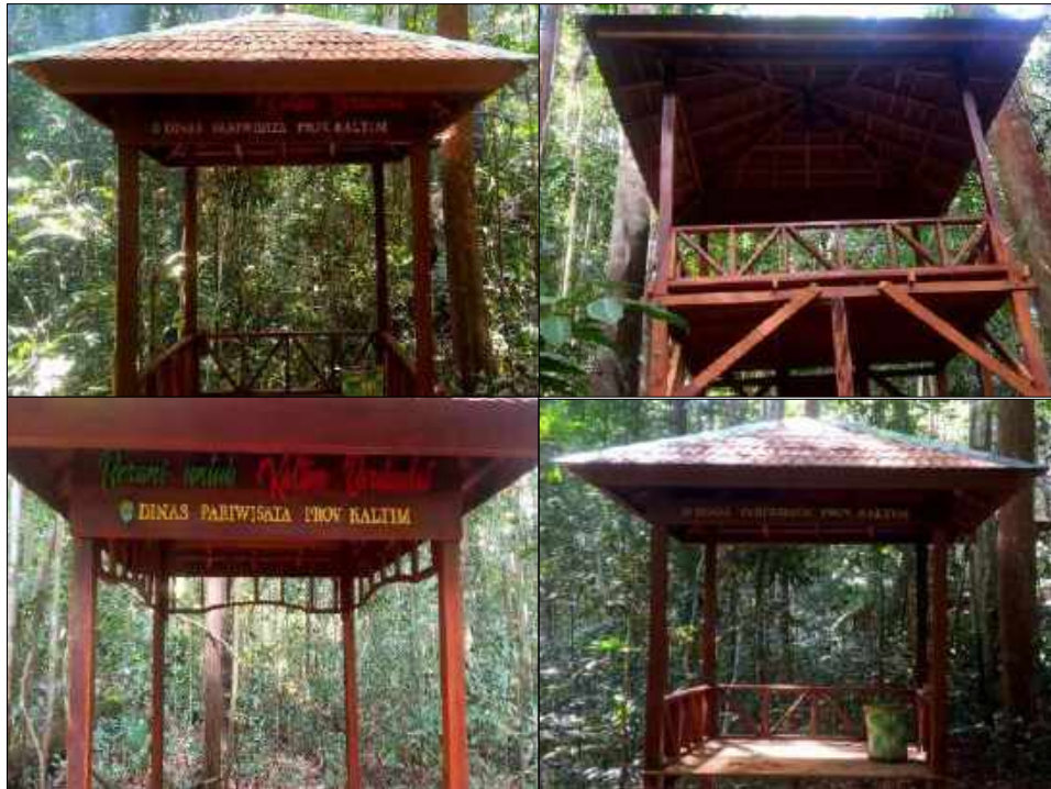
PEMBUATAN GAZEBO DI HEMAQ BENIUNG DESA JUAQ ASA (KAB. KUTAI BARAT. BULAN MEI AGUSTUS 2021)
